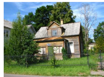
Attēls Nr. 62: Koka fona apbūve Tukuma ielā 19 (foto D.Stepiņa 08.2013.)
