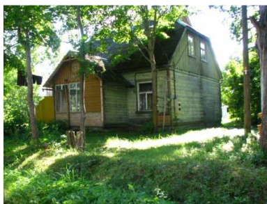
Attēls Nr.61 Koka fona apbūve Brocēnu ielā 3 (foto D.Stepiņa 08.2013.)
